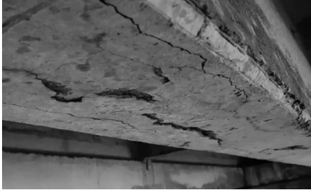
图 1 梁局部裂缝
