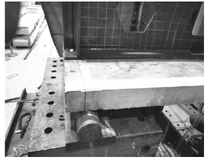
(b)支座处混凝土破坏
